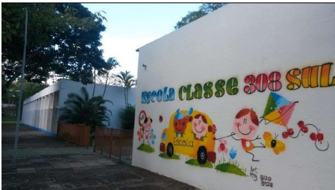
Foto 50 – Fachada da escola
